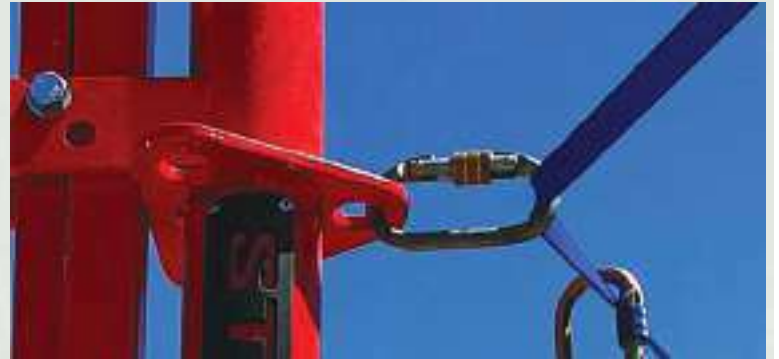
Adapter Systemu Linii Życia (punkt kotwiczący Typ B).
