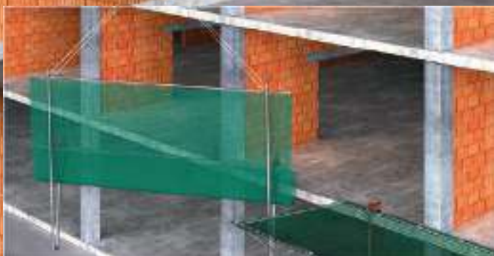
System modułowy mocowany od góry.
