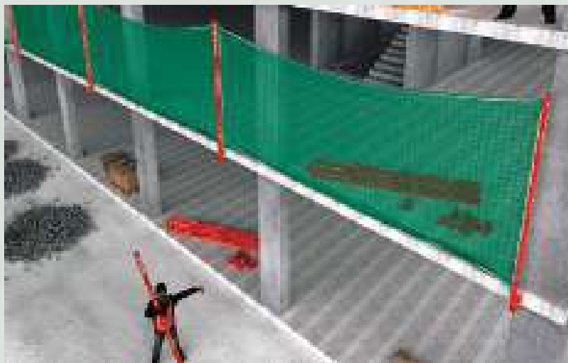
Moduł LiteMESH w konfiguracji mocowania czołowego.
